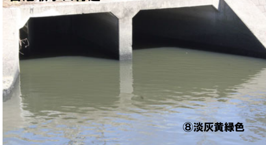
向田橋南 留池取水口付近
