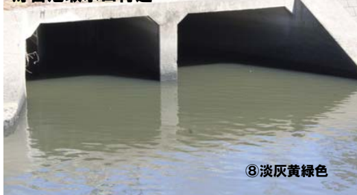
向田橋南 貯留池取水口付近
