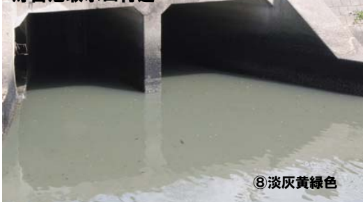
向田橋南 貯留池取水口付近
